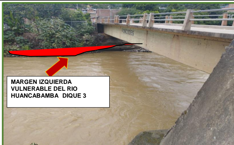
FIGURA N°03: TRAMO CRÍTICO EN EL RÍO HUANCABAMBA , PUENTE CARROZABLE EN PELIGRO
